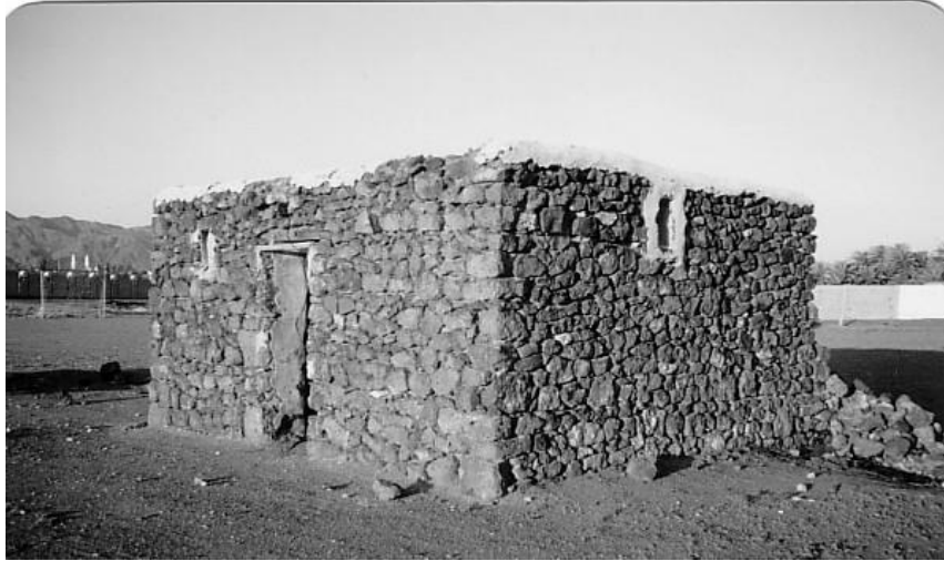
إحدى غرف مطار المدينة المنورة القديم بجوار الجامعة الإسلامية وقد بني بالحجر غير المنتظم
