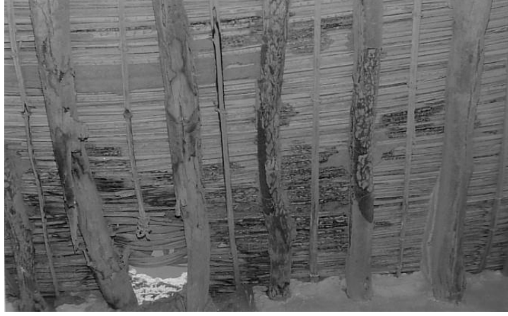
تفاصيل أحد أسقف المباني التقليدية والتي شيدت من جذوع الطرفة والجريد
