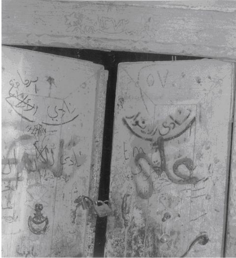
صورة الباب الرئيسي لأحد المباني التقليدية القديمة بمنطقة باب المجيدي ويظهر على شكل مستطيل يتكون من ضلفتين يحيط بهما إطار ثابت من الجهات الثلاثة ، وقد دُون على الإطار العلوي تاريخ إنشائه وهو عام ١٣٧٢هـ.
